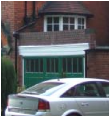
Part-glazed garage doors, H'n & Pk Villas
